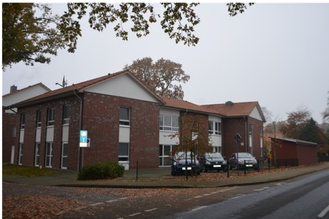
Wo heute in Oldendorf eine Seniorenwohnanlage steht, war früher ein Bauernhof. Fotos: von Allwörden
